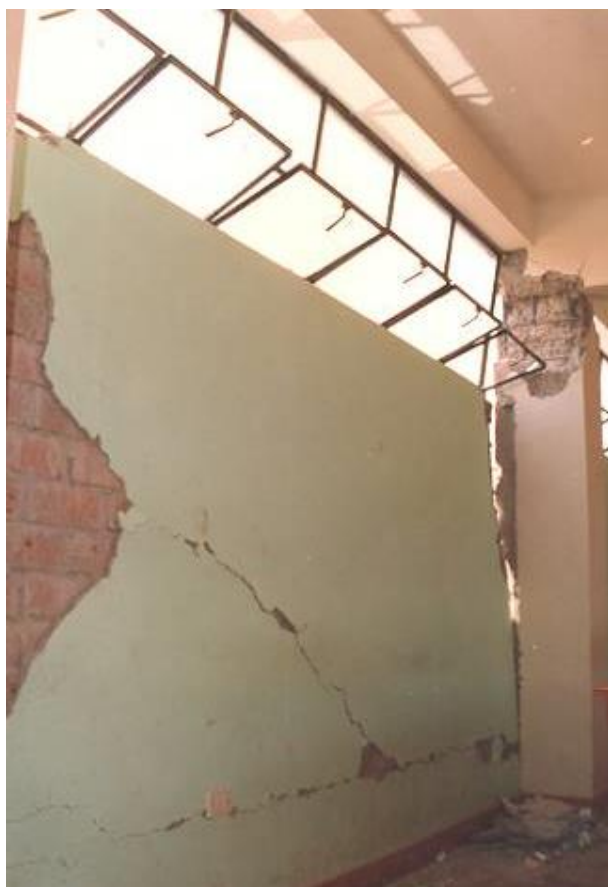
Fig. 8.- Colegio Fermín del Castillo, Vista Alegre, Nasca. Fallas en alféizar de ventana alta.
