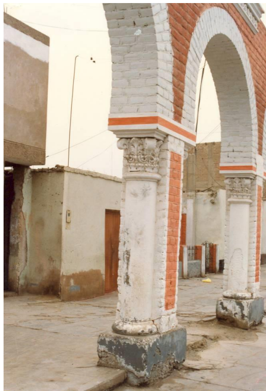
Fig. 13.- Portales frente a la iglesia de Luren, Ica. Falla en la base, sistema inestable.
