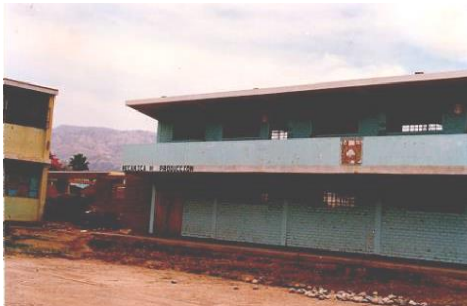
Fig. 5.- Colegio Fermín Tangüis, Palpa. Pabellón sin daños.
