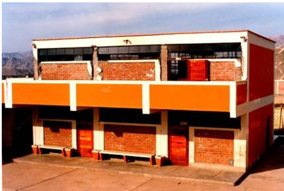
Fig. 6.- Colegio Fermín del Castillo, Vista Alegre, Nasca. Daños en el segundo piso.
