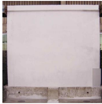
Figura 11. Muro M3, reparado y reforzado
