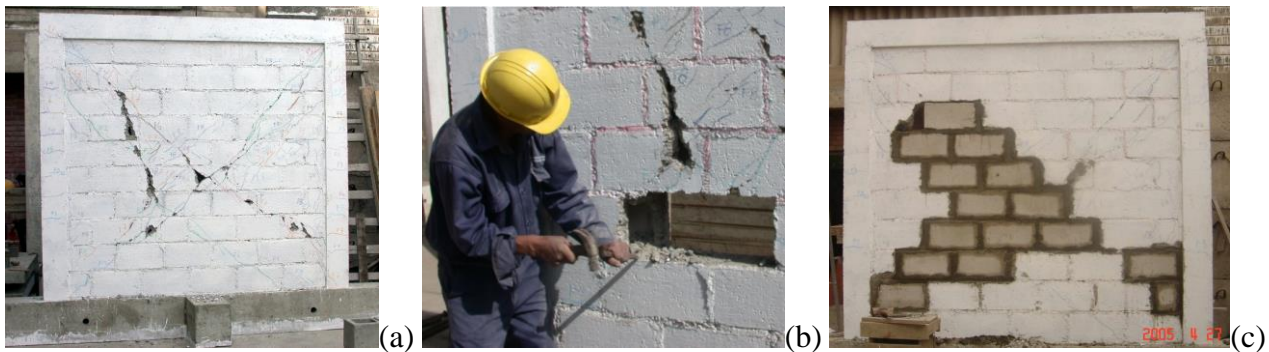
Figura 9. Evaluación del muro M1 y reemplazo de unidades
