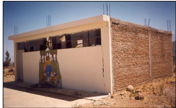
Figura 4. Falla por columna corta en ambos ejes longitudinales de centro educativo, Arequipa 2001.
