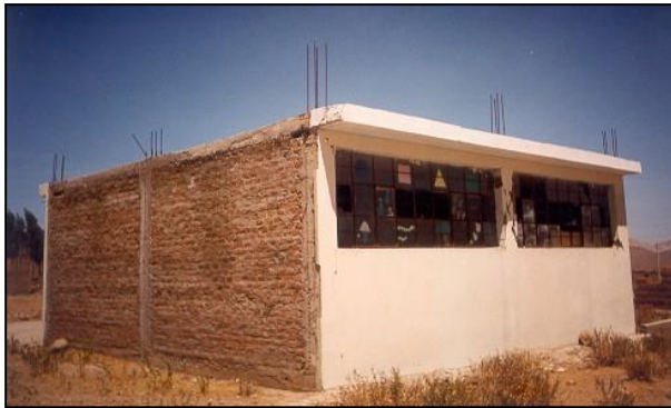
Figura 4. Falla por columna corta en ambos ejes longitudinales de centro educativo, Arequipa 2001.
