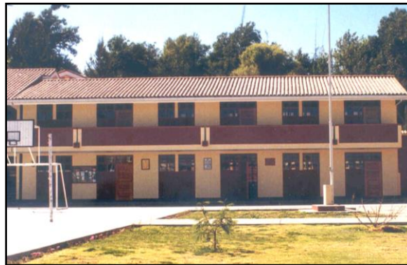
Figura 6. Edificios educativos modernos construidos con la Norma de 1997, sin daños
