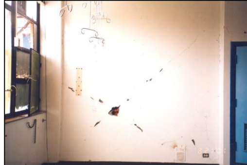
Figura 7. Hospital en Arequipa-Edif. de 7 pisos Figura 8. Tabiques dañados en Hospital
