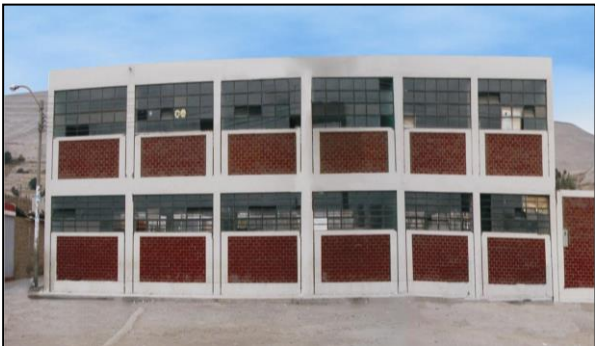
Figura 14. Edificio de dos pisos antes del reforzamiento.
