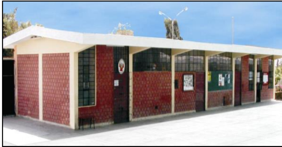
Figura 12. Edificio de un piso antes de la intervención
