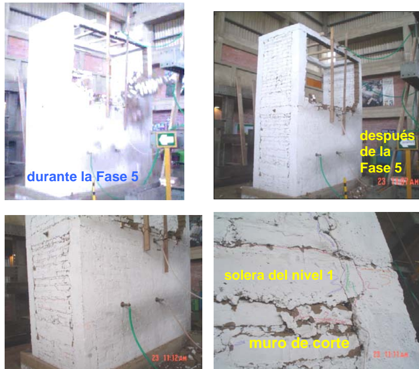
Fig.12 Estado del Módulo en la Fase 5.
