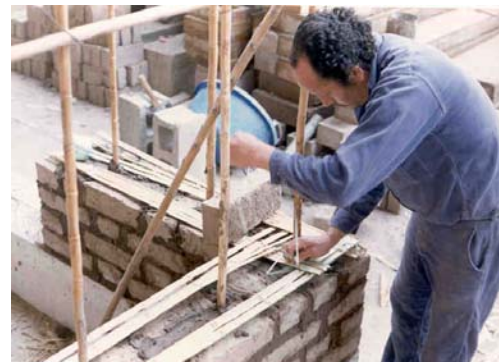
Fig. 1. Uso de cañas como refuerzo en el interior de los muros de adobe.
