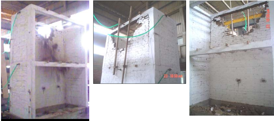
Fig.10. Módulo de 2 pisos, durante la fase 4 (izq.) y después de la fase 4 (centro y der.).
