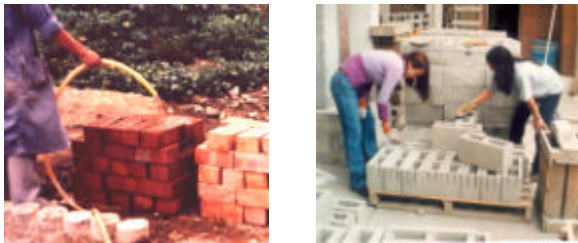
Fig. 2. Tratamiento de unidades antes del asentado: regado de ladrillos de arcilla (izq.) y limpieza con escobilla húmeda en bloques de concreto (der.).
