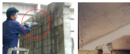
Fig. 6. Muro de ladrillos de arcilla huecos reforzado con malla electrosoldada, San Bartolomé y Castro (2003)
