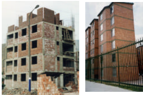
Fig. 12. Edificios peruanos de albañilería de hasta 5 pisos de altura (izq.), mientras que en Colombia, se permite más altura (der.)
