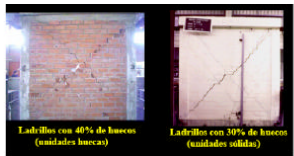
Fig. 5. Muros ensayados a carga lateral, las unidades huecas se trituran (izq.) y las unidades sólidas se mantienen (der.) San Bartolomé (2007).
