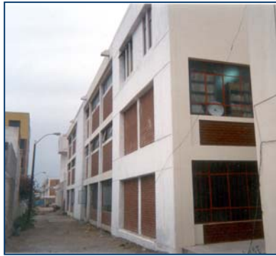
Figura 10. Edificio educativo de tres pisos reparado y reforzado
