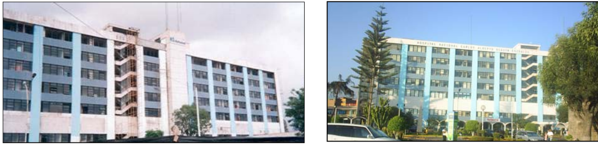
Figura 12. Reforzamiento sísmico del edificio del hospital de 7 pisos en 2003 (izq.) y 2005 (der.).
