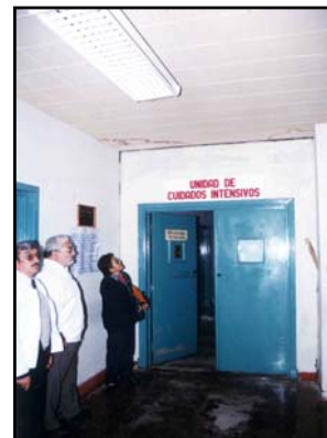
Figura 6. Hospital en Tacna: edificio de 5 pisos (izq.) con abundantes daños en tabiques y en las instalaciones sanitarias (der.), tras el terremoto del 2001.
