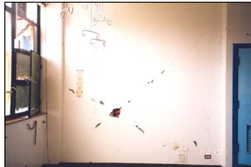
Figura 5. Hospital en Arequipa: edificio de 7 pisos (izq.) con abundantes daños en tabiques divisorios (der.), tras el terremoto del 2001.
