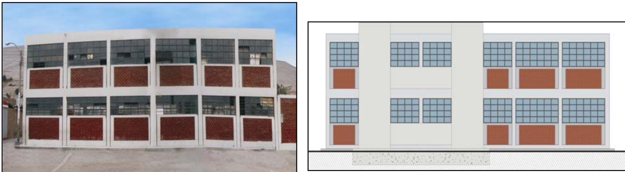
Figura 9. Edificio educativo de dos pisos antes de la intervención (izq.) y sistema de reforzamiento (der.)
