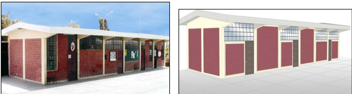
Figura 8. Edificio educativo de un piso antes de la intervención (izq.) y sistema de reforzamiento (der.)
