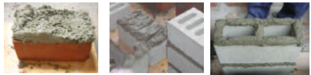
Fig.7. Mortero cubriendo la superficie de asentado. De izquierda a derecha: ladrillo de arcilla, ladrillo de concreto y bloque de concreto.
