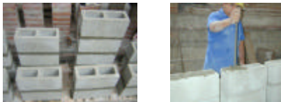
Fig.10 Secuencia en la construcción de pilas con bloques de concreto BCV. Pilas vacías (izq.) y compactación del grout (der.).
