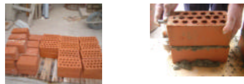
Fig.8 Ladrillos de arcilla humedecidos (izq.) y construcción de pilas (der.).
