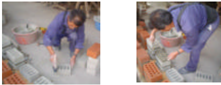
Fig.9 Secuencia en la construcción de pilas con ladrillos de concreto KKC. Limpieza (izq.) y asentado (der.)
